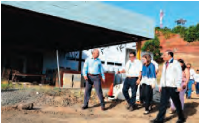
La ministra de Salud, Rosario Turner, visitó ayer el Minsa-Cap- si de Nueva Italia, junto al equipo de infraestructura. Cortesía
