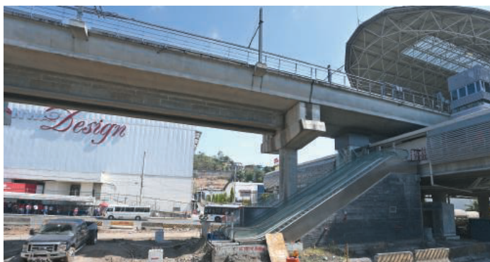
La extensión de la Línea 1 del Metro desde el sector de San Isidro hasta Villa Zaita tiene una extensión de 2.2 kilómetros y según cálculos la construcción debe tomar 33 meses desde la emisión de la orden de proceder.
