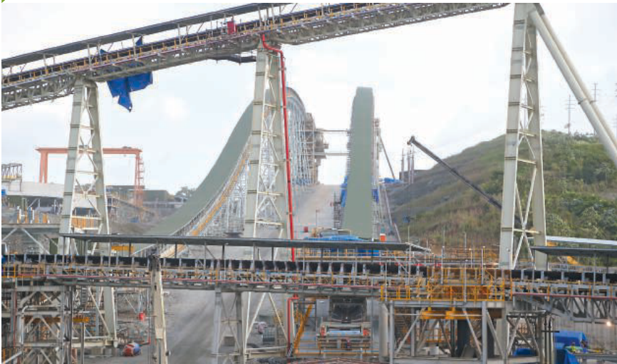
En 2017, el Gobierno extendió por 20 años adicionales la concesión que en 2013 First Quantum compró por 5 mil 100 millones de dólares. La empresa indica que durante la vida útil de la mina intervendrá 5 mil 900 hectáreas, de un total de 13 mil hectáreas que incluye el proyecto.
